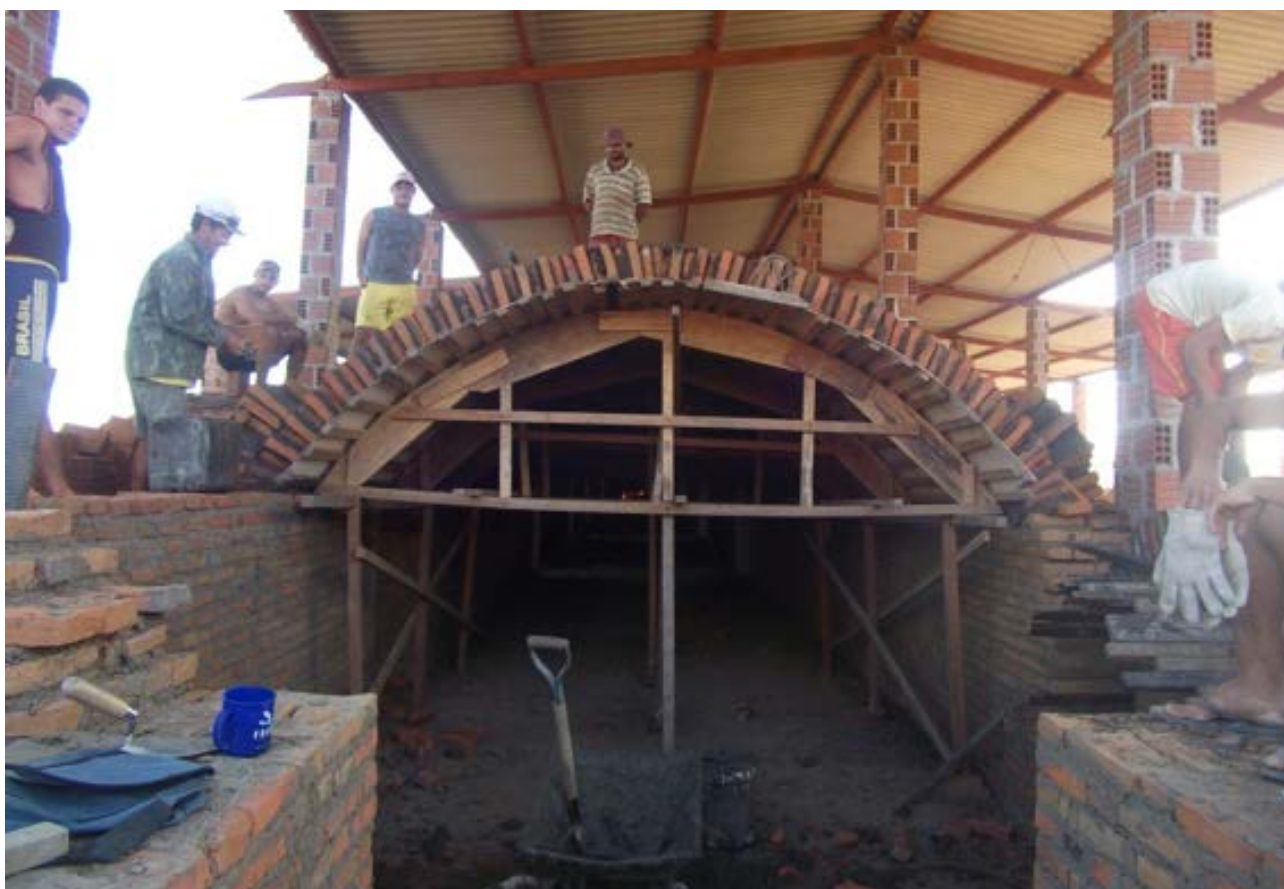
Figura 4.39: Hoffmann em construção em cerâmica na cidade de Tangará/RN na Grande Natal (Foto: autor).
